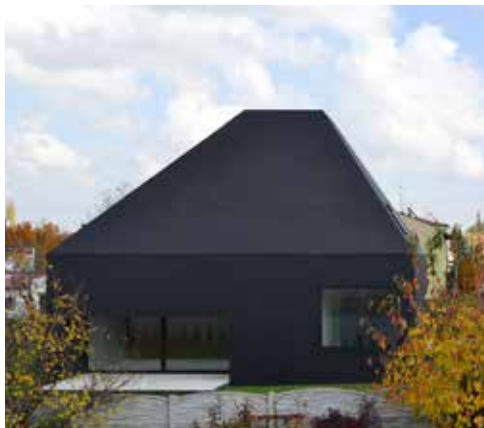
©Dyrda Fikus Architekci
